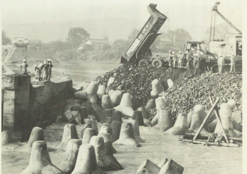
仮堤防締め切り工事完了の瞬間
