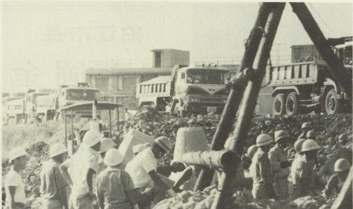
復旧資材を運ぶトラック
